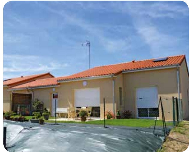
Saint-Rémy-en-Mauges / Montrevault-sur-Èvre - 8 logements Le Clos Saint Michel
