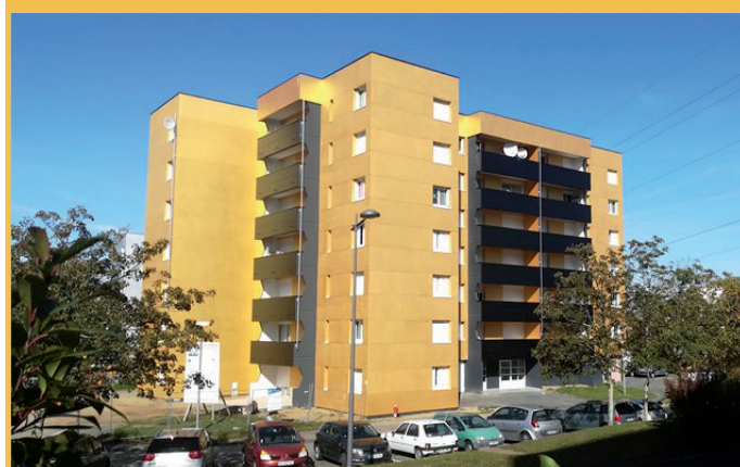
Photos près travaux
