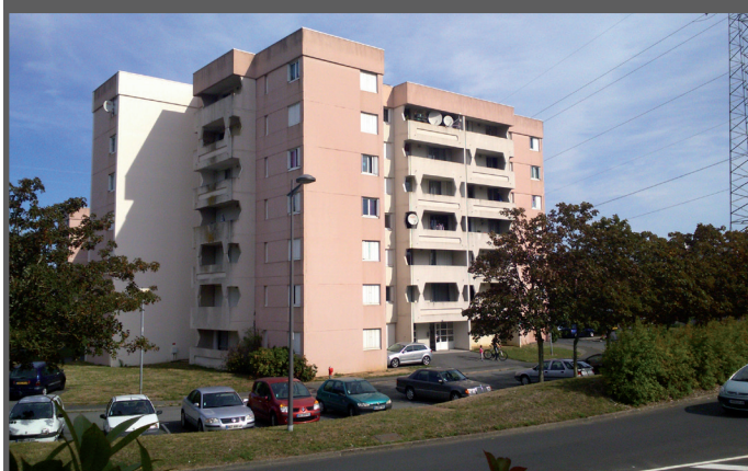
Photos avant travaux
